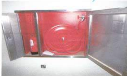
صناديق إطفاء الحريق Fire Hose Reel Cabinets with Fire Extinguishers
