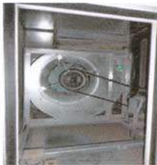
مراوح سحب الدخان في وحدات مناولة الهواء Smoke Extraction Fans Integrated from AHU
