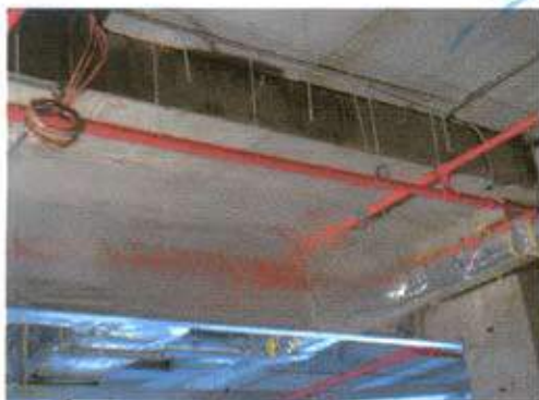
( معالجة إختراق الأنابيب وحوامل الكابلات أعلى السقف Fire Stopping )
