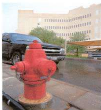
Fire Hydrant وصلات اطفاء الحريق
