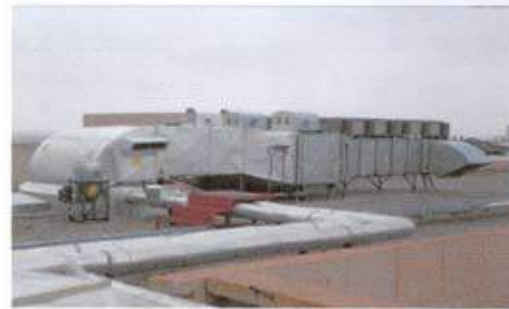
مراوح سحب الدخان في وحدات مناولة الهواء Smoke Extraction Fans Integrated from AHU
